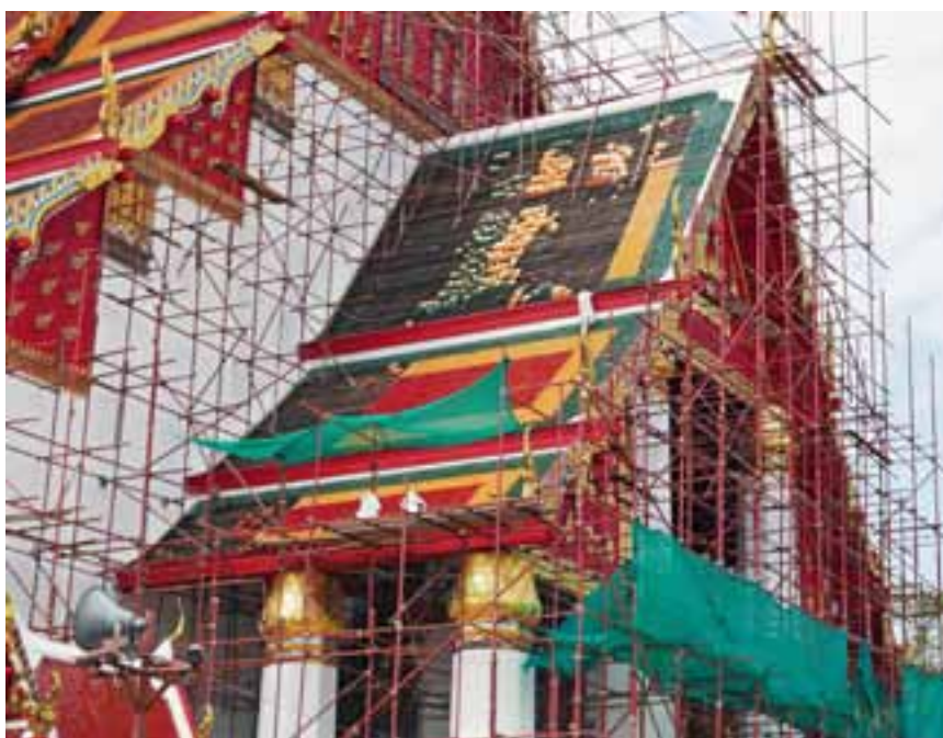
Nicht ganz BG-konform, aber dennoch wird am Tempel mit Stahlgerüsten gearbeitet.
