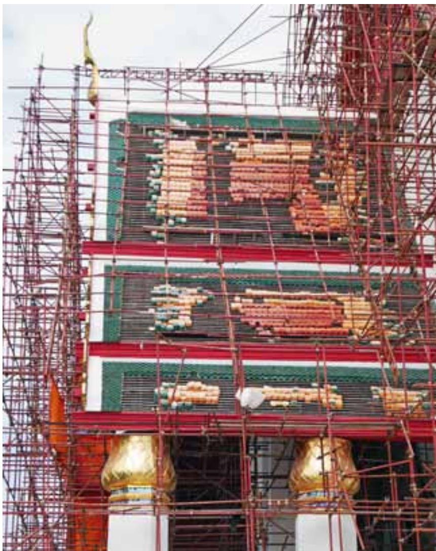
Zur Eindeckung bereit lagern die Ziegel wie auch bei uns zu Lande griffbereit auf den Dachlatten.
