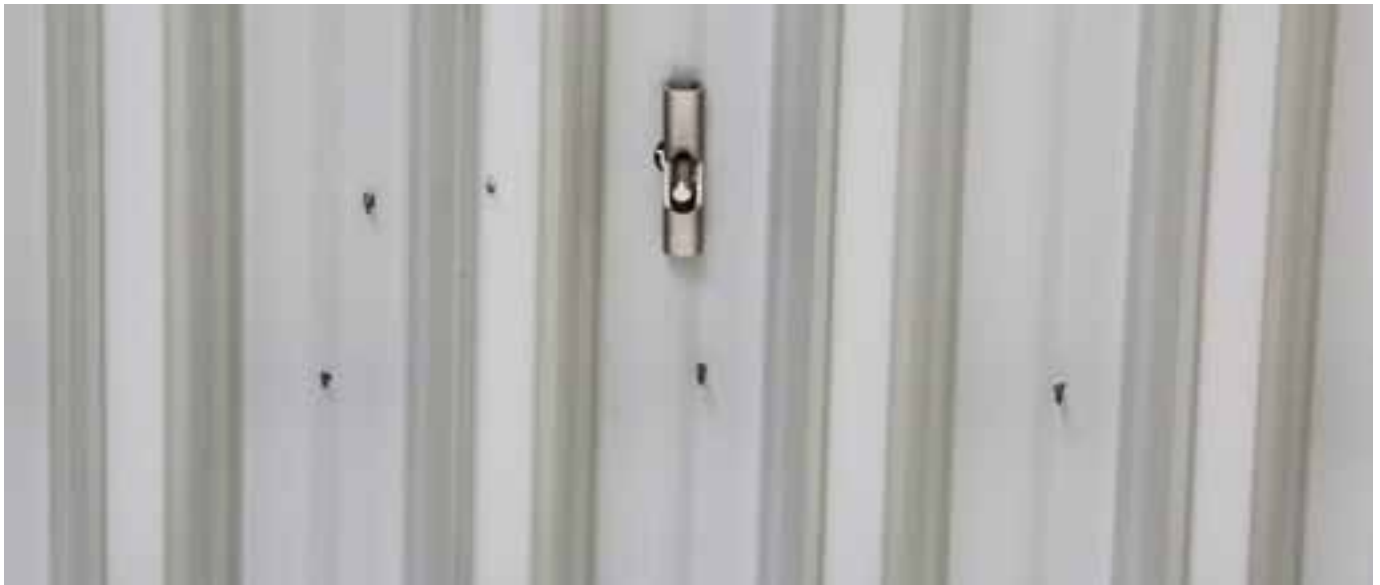
Unteransicht: Die Voraussetzung für den Einbau des Kippdübels ist, dass das Trapezblechprofil eine Mindestdicke von 0,75 mm aufweist.
